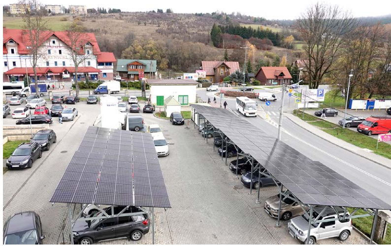
270 000 zł – tyle wydała dyrekcja powiatowego Szpitala im. J. Dietla w Krynicy-Zdroju na montaż instalacji fotowoltaicznej o mocy 50 KW. Urządzenia zamontowane na zadaszeniu parkingów powinny zabezpieczyć część zapotrzebowania na energię elektryczną.
