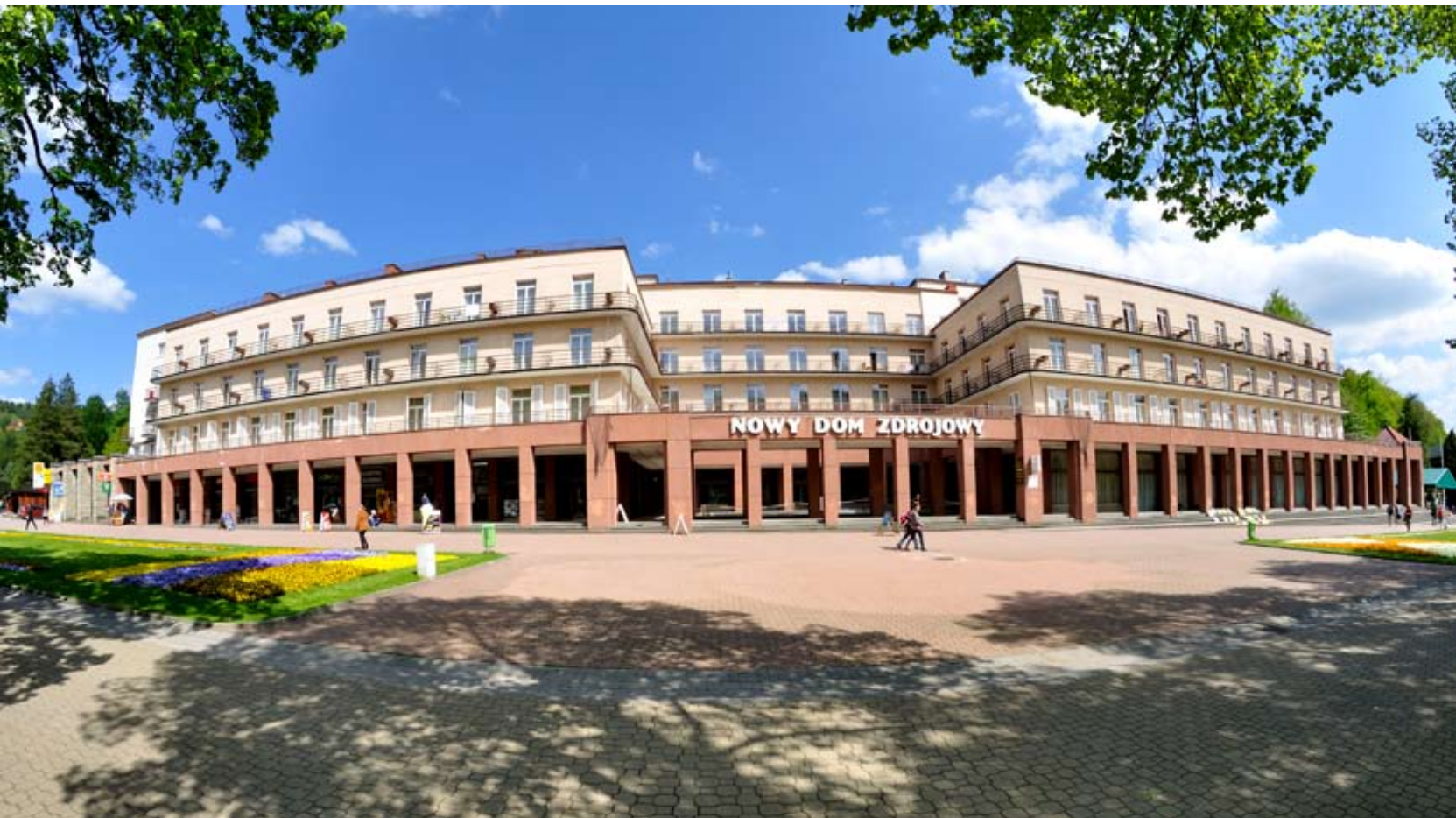
Nowy Dom Zdrojowy w Krynicy-Zdroju | Nový Kúpeľný dom v Krynicy-Zdroju | New Health Resort House in Krynica-Zdrój fol. A.Klimkowski
